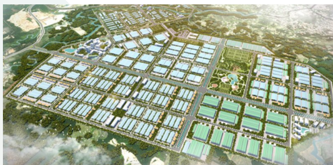
Dự án đầu tiên: Khu công nghiệp Gilimex Huế
